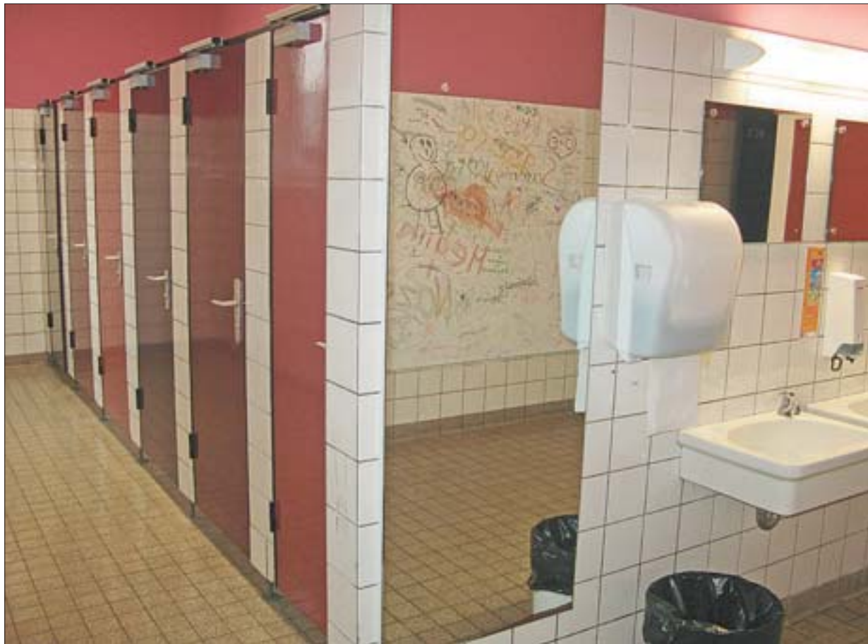
Mit 450 000 Euro will die Stadt im nächsten Jahr die Robert-Koch-Realschule sanieren. Allein für die neuen sanitären Anlagen plant die Verwaltung 300 000 Euro ein. Hahn
